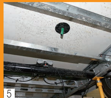
5. Une barre de renfort est installée sur le châssis entre l'essieu et une traverse pour limiter les effets de torsion sur le châssis lors de la poussée des vérins.
