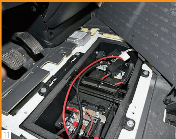
11. Le circuit d'alimentation de la pompe est branché sur la batterie moteur et protégé par un fusible de 125 A.
